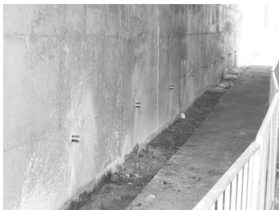
Figura 5. DRILL DRAIN® per il risanamento del ponte autostradale sulla A14 a Deutschenbora, Germania.
