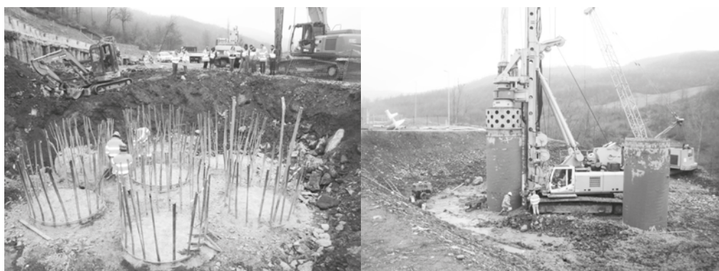
Figura 3. Bauer BG40 – Gestione del rivestimento e fondazione realizzata
