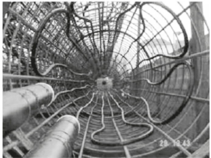
Figura 1. Palo energetico: dettaglio dell'installazione dei tubi del circuito primario di un sistema GSHP alla gabbia d'armatura dell'elemento strutturale.
