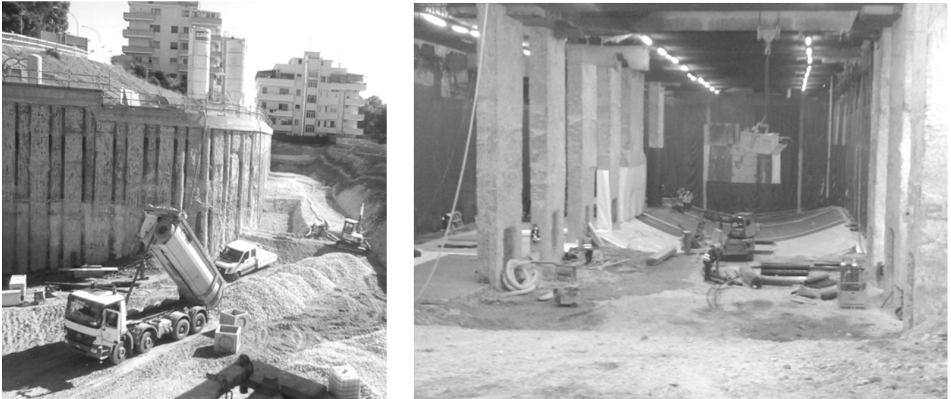
Figura 1: opera di sostegno di monte (a sinistra); ultimo ribasso e getto del solettone di fondo della stazione (a destra)
