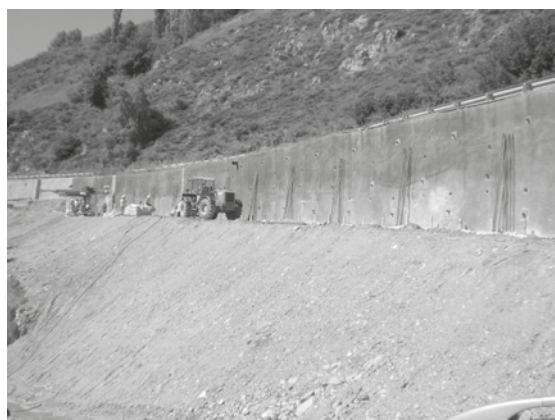
Figura 6. Drenaggi DRILL DRAIN® lunghi 14,00 m per eliminare la spinta idrostatica sul muro di spalla. Sauto (F)
