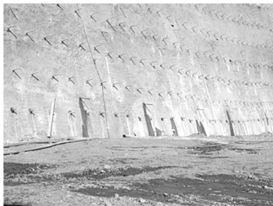
Figura 4. DRILL DRAIN® sulla parete chiodata di Kappl, Tirolo. Si nota la fuoriuscita dell'acqua dai drenaggi bassi.
