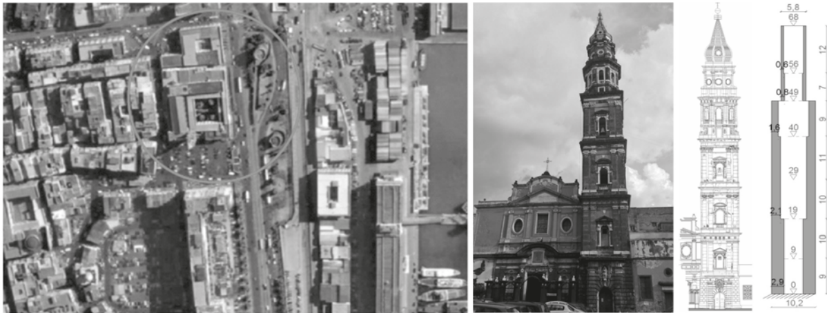
Figura 1. Foto aerea (a), facciata (b), prospettiva (c) e modello strutturale (d) del Campanile del Carmine.
