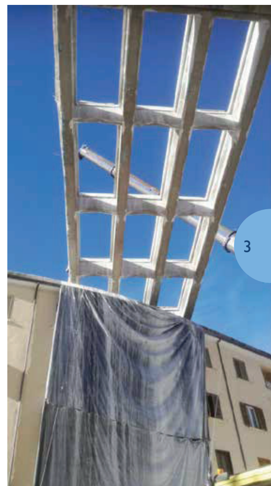
Struttura portante dell'impalcato centrale del ponte Belvedere "svuotato" della soletta superiore. In evidenza le quattro travi longitudinali ed i setti di collegamento trasversali.
