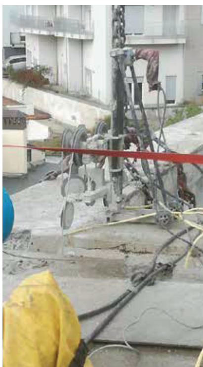
Attrezzatura impiegata per il taglio del c.a. con filo diamantato. In evidenza le carrucole di rinvio e i tubi dell'acqua per il raffreddamento.
