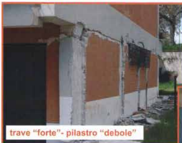
collasso a taglio in un pilastro
