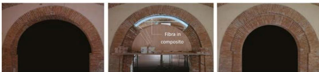
Esempio applicativo di rinforzo mediante creazione di sottarco laterizio armato con funzione di cerchiatura
