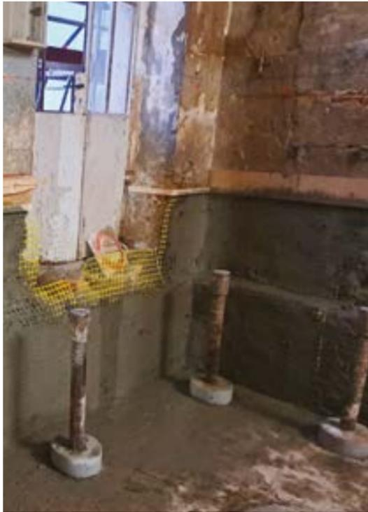
Figura 2. Posa di Bi Mortar Plaster Seal e Revomat
